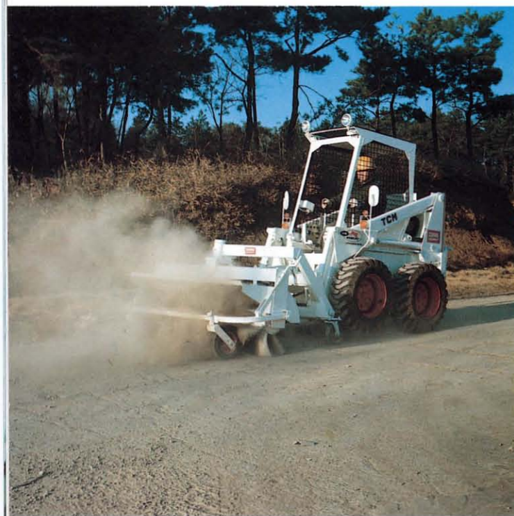
道路・配管工事
