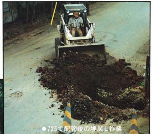
●725で配管後の埋戻し作業
