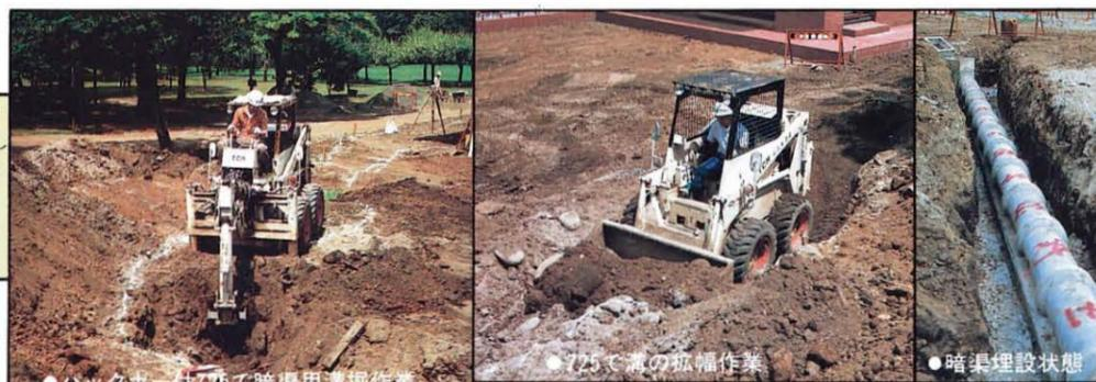
●バックホー付725で暗渠用溝掘り作業
