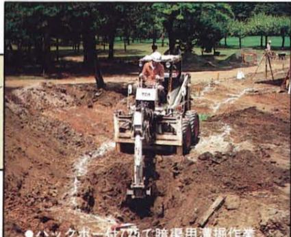
●バックホー付725で暗渠用溝掘り作業
