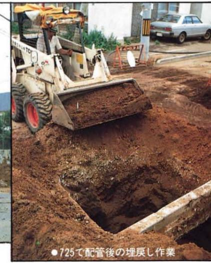
●725で配管後の埋戻し作業
